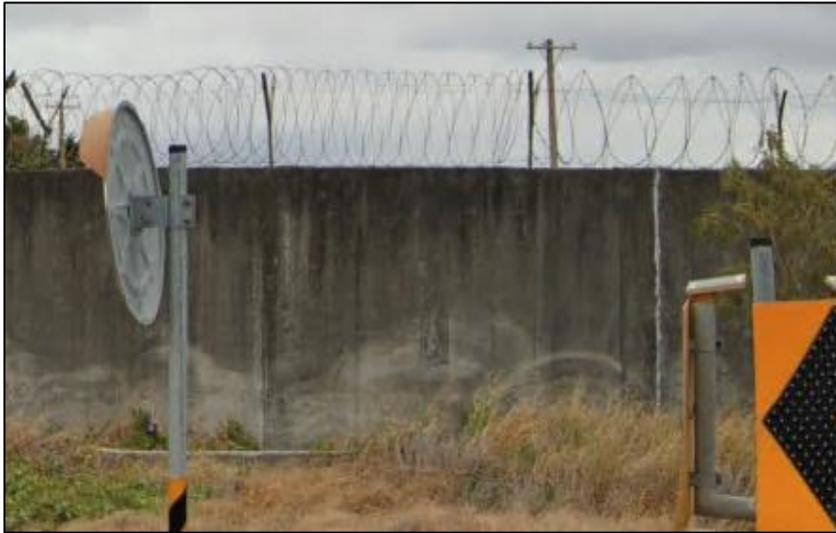
圖 11—機場外圍大多是設置混凝土牆搭配鐵絲網實施防護
