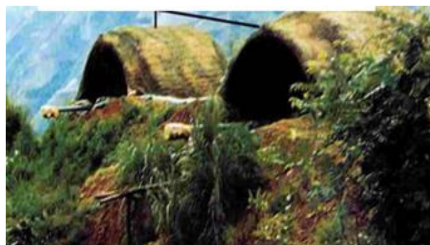
圖 18 預鑄工法構築之砲兵掩體(環片式混凝土設施)
