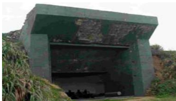
圖 17 鋼筋混凝土構築之砲兵掩體
