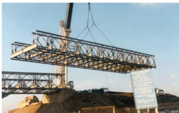
圖 6 運用大型起重機吊掛方式快速架設 資料來源：英國 Mabey & Johnson 公司接裝訓練簡報資料。
