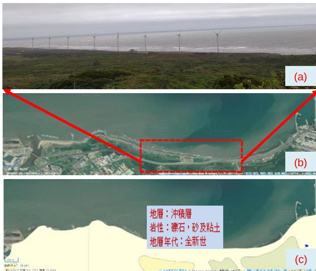
圖 5 寶斗厝海灘現地照片(a)、衛照圖(b)、及地質圖(c)-藍色旗幟為林口發電廠
