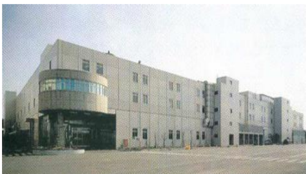
圖 3 東元電機廠房預鑄帷幕牆工法(清水面帷幕牆)
