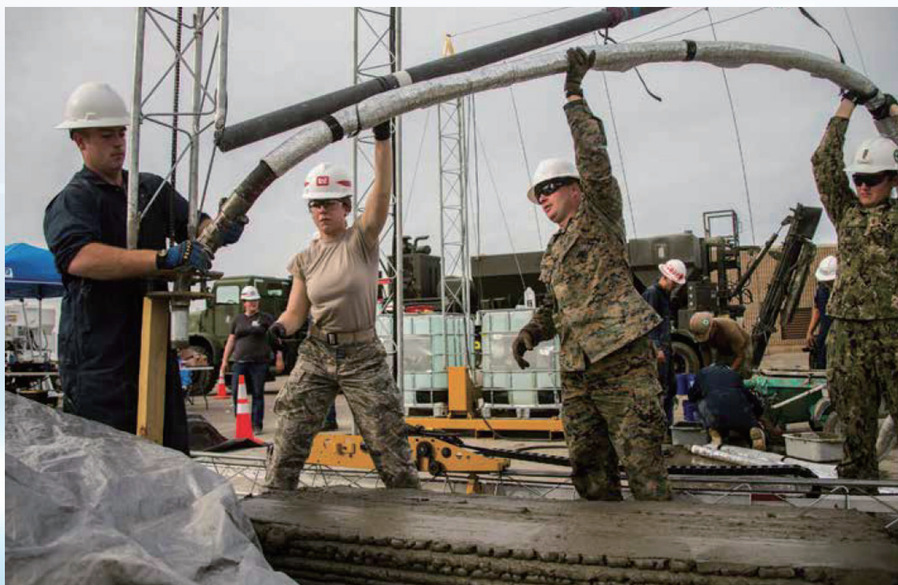
2018年12月9日，美陸戰隊第7工程支援營(Engineer Support Battalion)及美海軍第5機動工程營(Naval Mobile Construction Battalion)士兵於加州朋德爾頓(Camp Pendleton, California)舉行的3D混凝土列印演習(3D Concrete Printing Exercise)期間，合力將軟管連接上3D混凝土印表機。(Source: USMC/Betzabeth Y. Galvan)
