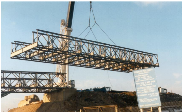
圖七吊車吊掛橋樑
