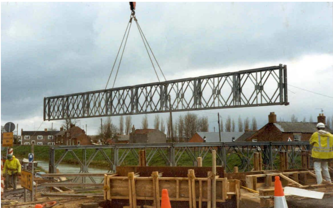
圖四 吊車吊掛橋樑
