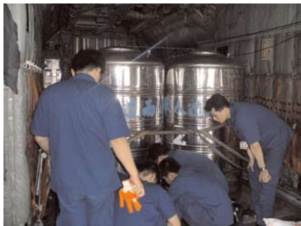
圖三 空中人工增雨任務執行前，機上需先進行空中噴灑催化劑之容器安裝、水管佈建與整備等前置作業
