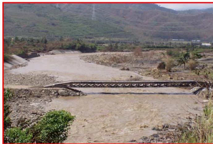
圖 9：楓港橋架設完成實況
