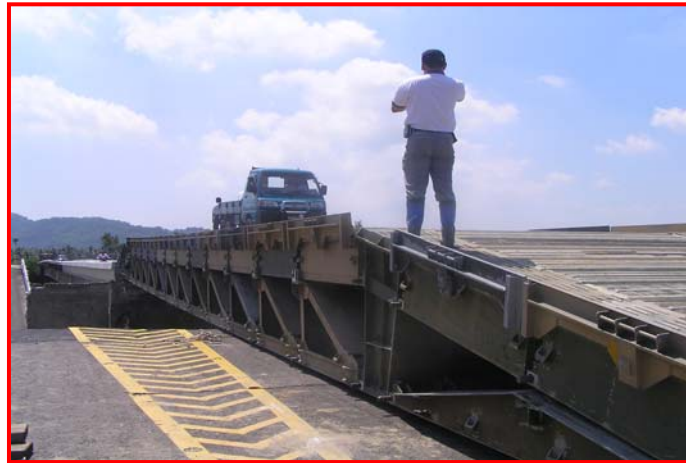
圖 10：溪州大橋架設完成實況
