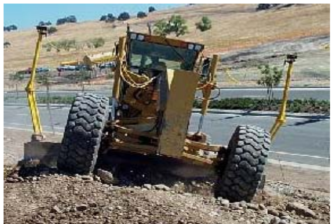
圖 29：平路機刮平鋪散精密作業示意圖
