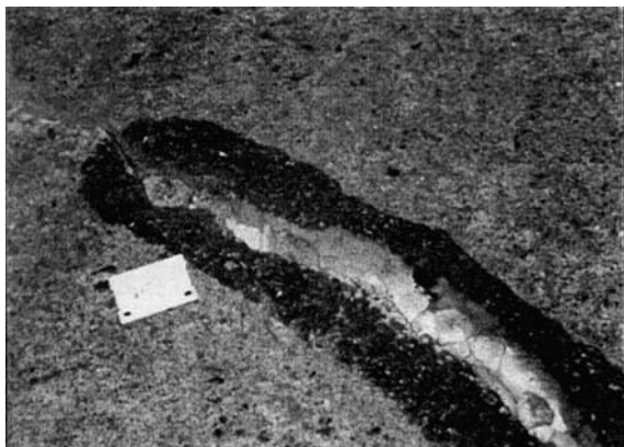
圖5 剛性道面修補後再破壞
