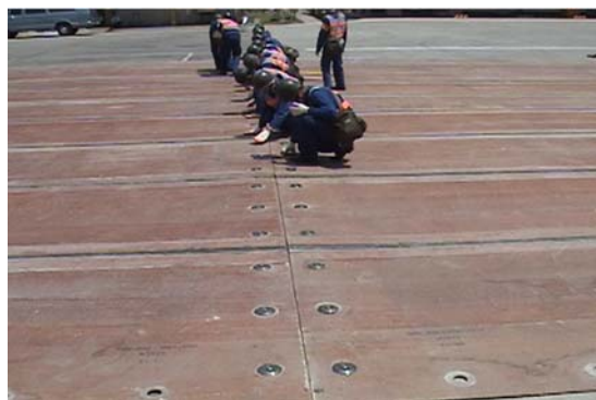
圖 3、4 機場跑道搶修包鋪設演練【4】
