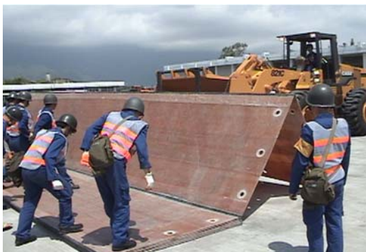
圖 3、4 機場跑道搶修包鋪設演練【4】
