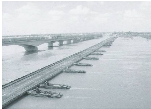
圖四 美軍架設於底格裏斯河上536公尺長的改良式浮橋
