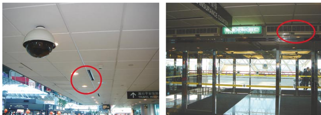
圖五 機場中央空調進、排氣口位置圖
