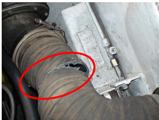
圖六~空氣濾清器進出氣軟管破損應實施更換
