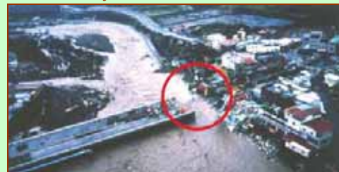
圖 35、楓港大橋引道流失空照圖
