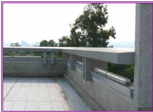
造型鋁包版及坡度設計，有效避免雨水垂流污染牆面並能收集雨水供灌溉草木之用
