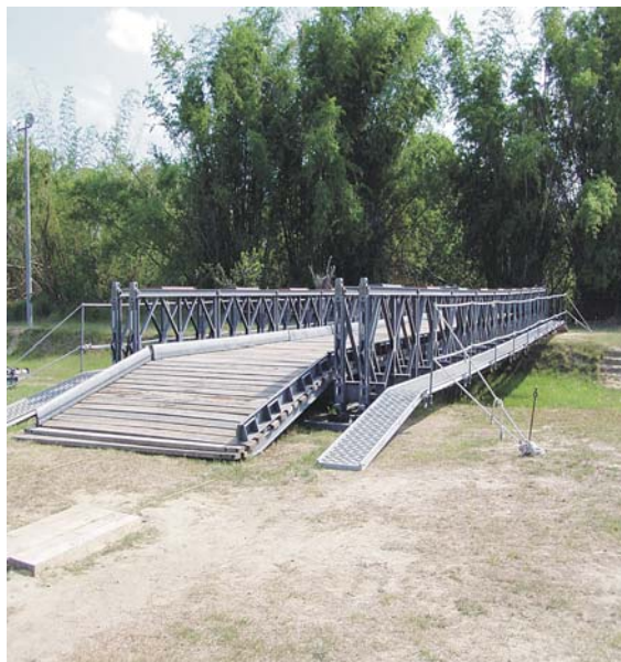
圖三 M2框桁橋
