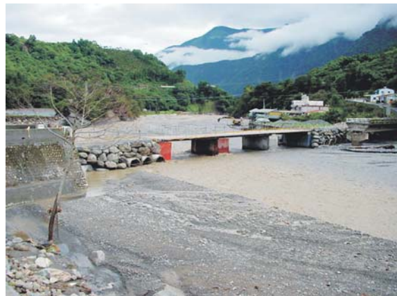
圖九 架柱式鋼桁橋
