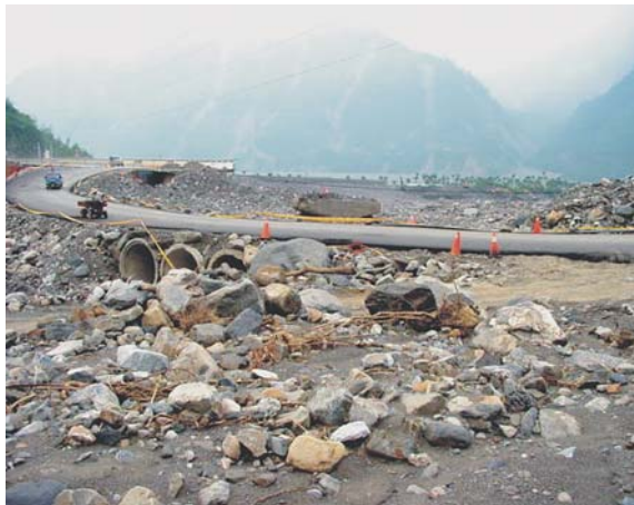
圖七 河床便道
