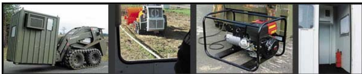
圖18 B5排雷車遙控艙內部及附屬發電機
