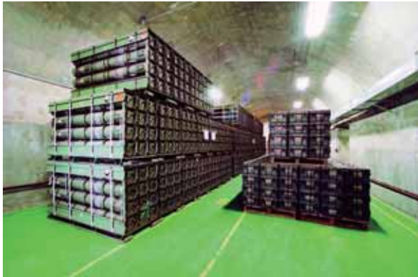
◎ 落實彈藥庫儲管理，整建庫儲設施，減輕部隊管理負荷，確維彈庫及作業安全。
