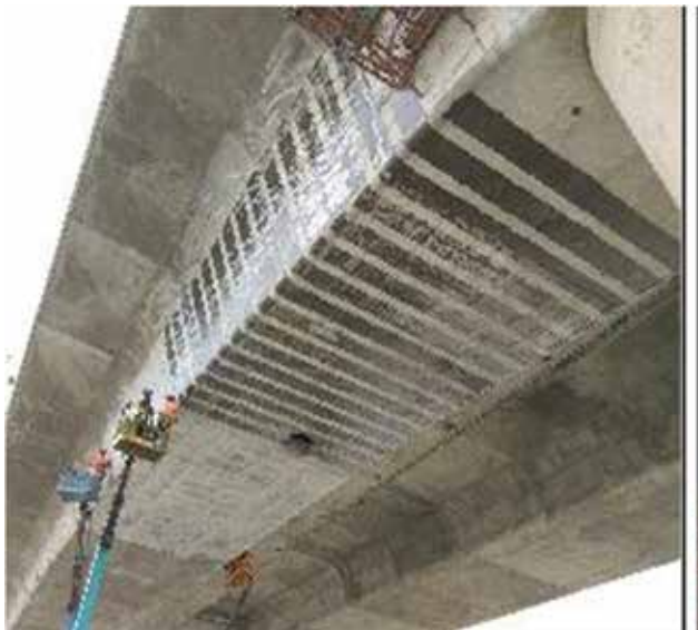
圖9 鋼筋混凝土構件碳纖維貼片補強狀況
