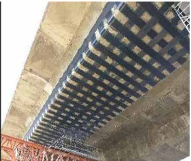
圖9 鋼筋混凝土構件碳纖維貼片補強狀況
