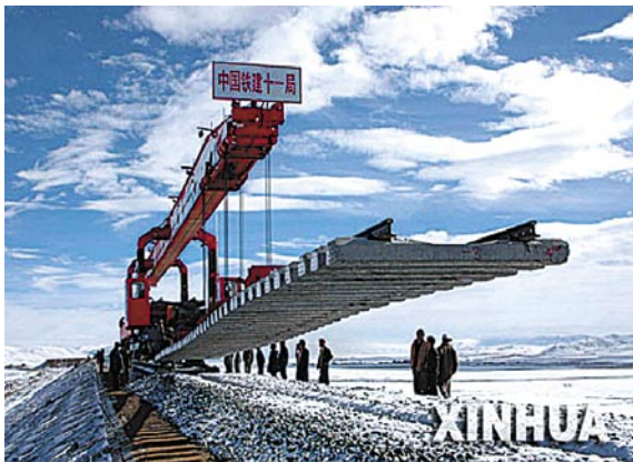
圖十一 凍土區施工情形
