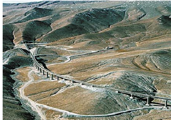
圖十二 青藏鐵路穿越多年連續凍土區長達550公里，為世界上穿越凍土區里程最長的高原鐵路
