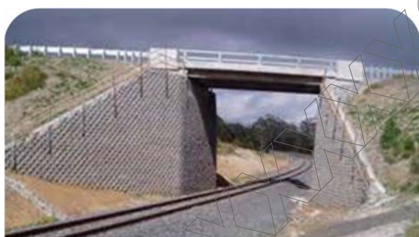
注意：如果翼牆可以支撐重建或臨時橋樑，請按照與橋樑相同的方式在翼牆後面放置裝藥來摧毀翼牆。
