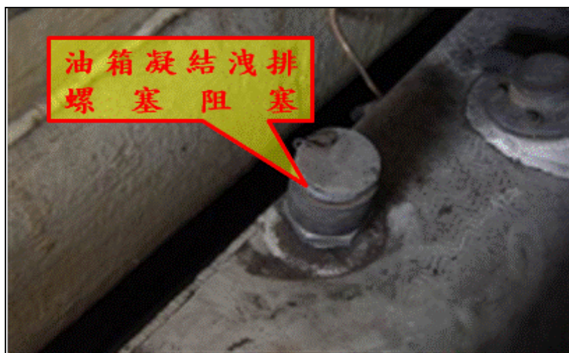
圖 16-油箱凝結洩排螺塞阻塞
