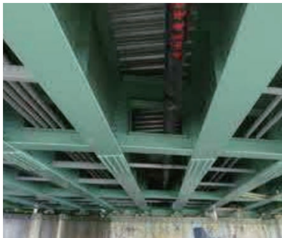
圖五 無人機巡檢橋梁管線
