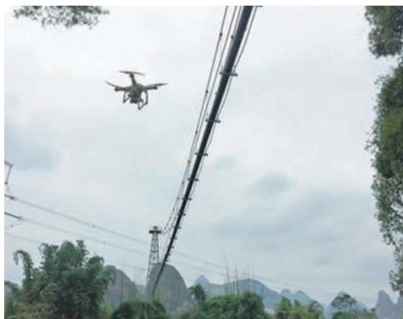
圖六 無人機巡檢懸索跨越輸油管線
