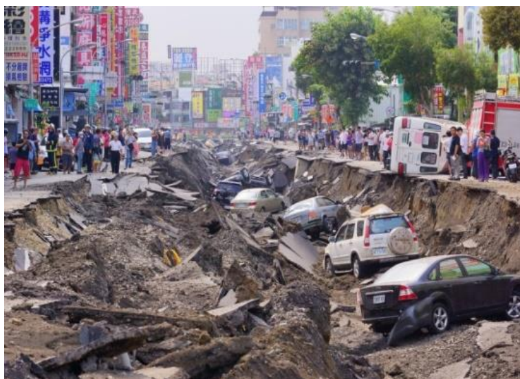
圖2 高雄氣爆災區現場
