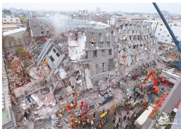
圖6 臺南大地震建築物倒塌
