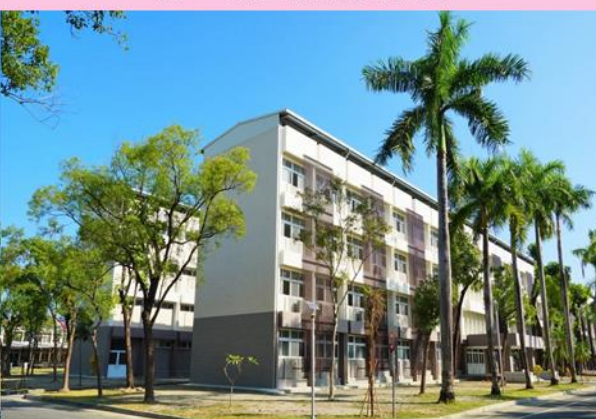
圖9 A兵舍施工後左側圖
