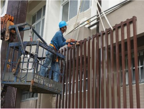
圖 14 外牆鋁格柵安裝施工 資料來源：現場監工拍攝。
