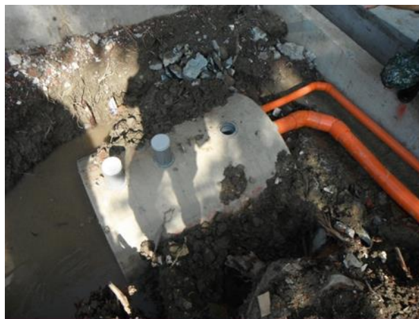
圖13 化糞池整修施工 資料來源：現場監工拍攝。
