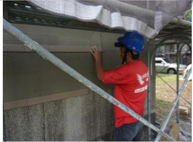
圖 15 外牆貼磚施工 資料來源：現場監工拍攝。
