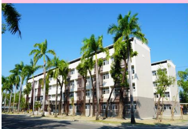
圖8 A兵舍施工後右側圖
