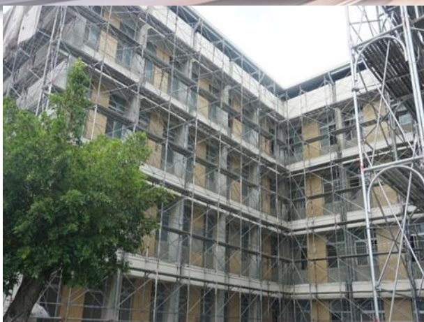
圖10 施工架組立 資料來源：現場監工拍攝。
