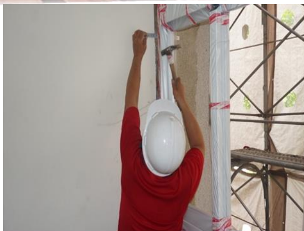
圖11 鋁門窗安裝 資料來源：現場監工拍攝。
