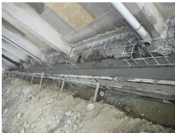
圖12 排水明溝施工 資料來源：現場監工拍攝。
