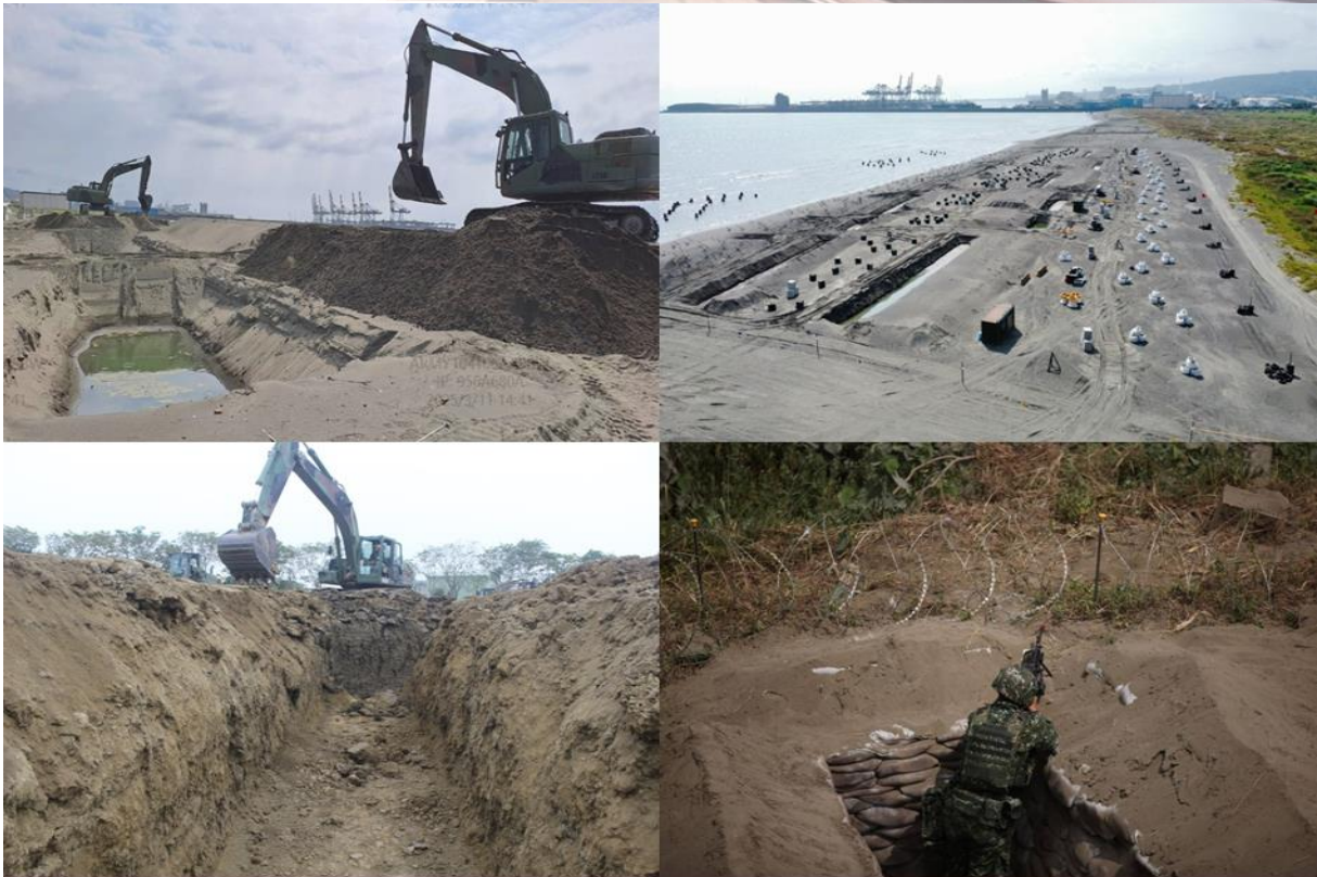
圖9 工兵機械於灘岸掩體構築之運用
