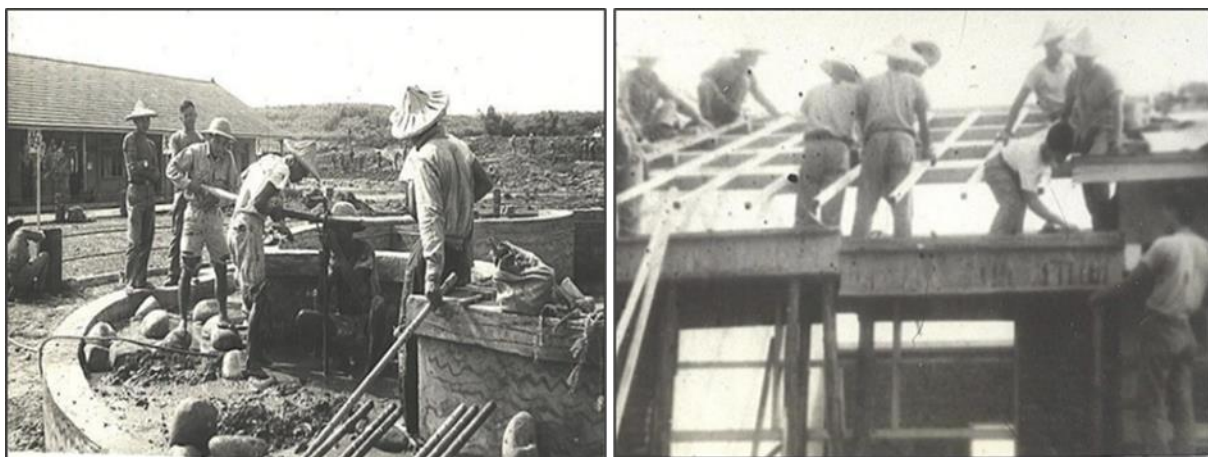
圖24 高雄大寮忠義國小整建施工照片 資料來源：校友陳貴先生提供。
