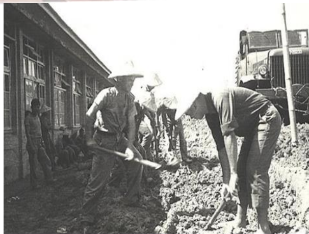
圖7 校園設施挖掘構築施工照片 資料來源：校友陳貴先生提供。
