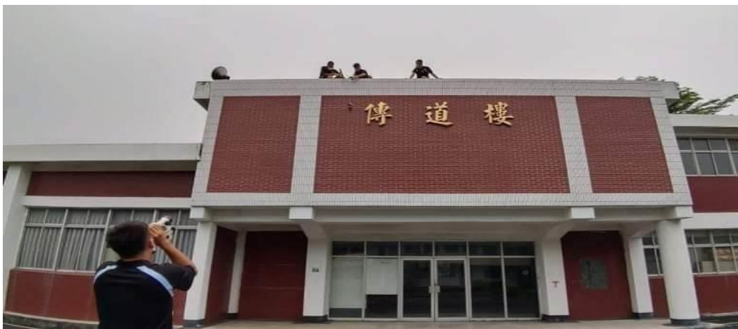
圖 3-8 實測傳道樓牆面
