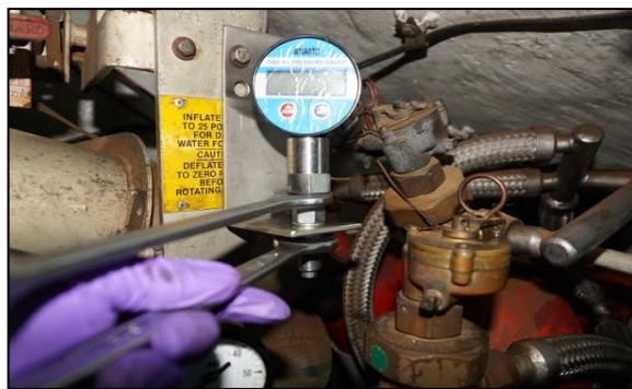
圖 66-安裝數位壓力表併緊定
