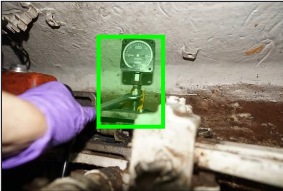
圖 71-安裝三通管併緊定
