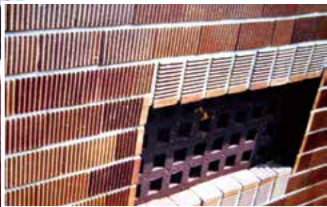
▲十三溝面磚不易反光，能有效避開盟軍戰機偵察【照片由作者提供】。
