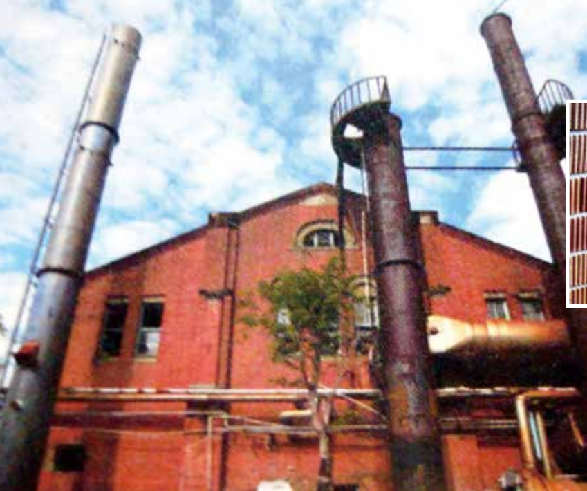
▲十三溝面磚不易反光，能有效避開盟軍戰機偵察【照片由作者提供】。
