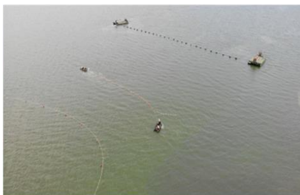
6.設置完成概況
