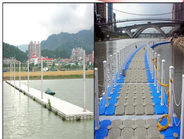
圖5 臨時浮動平台、走道示意圖(二重溪鐵人活動臨時搭設平台、走道)
