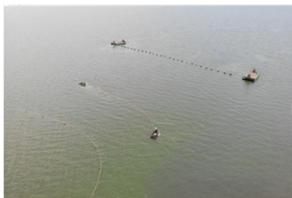
4.設置完成概況
