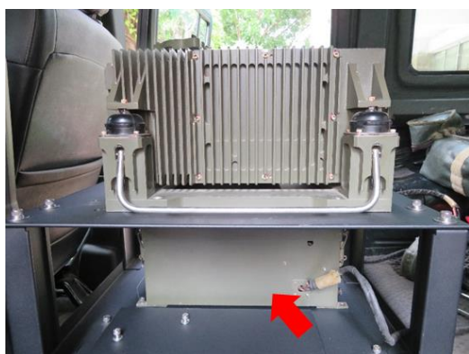
圖 22 安裝系統電瓶箱 BCU
