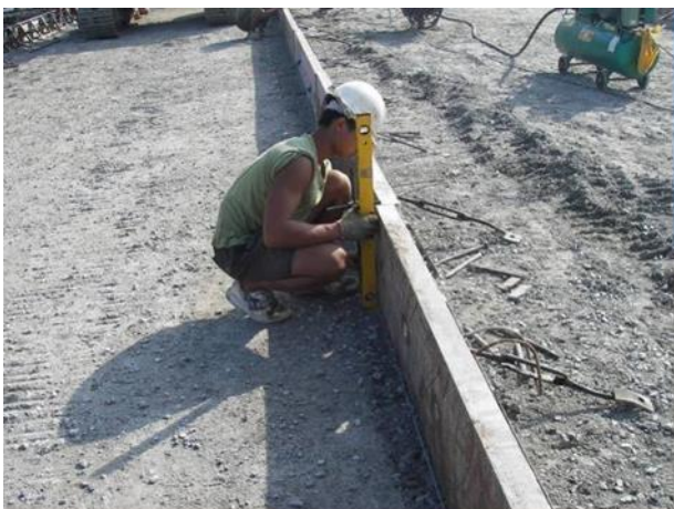
圖24 鋼模水平及垂直面檢測
