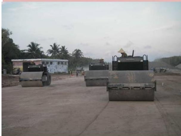
圖22 壓路機整地夯實
