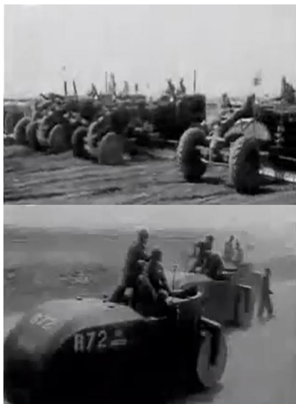
圖5 機場整建工程機具作業圖
