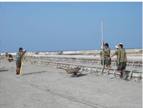
圖25 鋼模高程檢測
