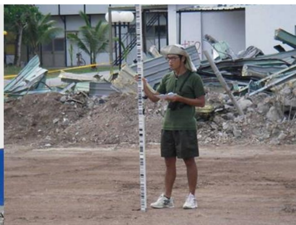
圖19 高程控制測量
