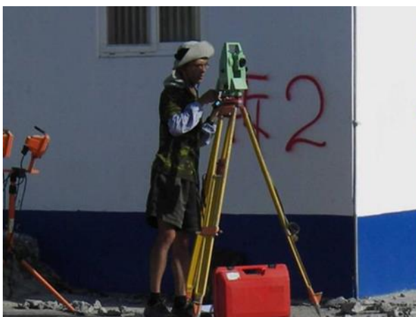
圖18 全區放樣高程檢測
