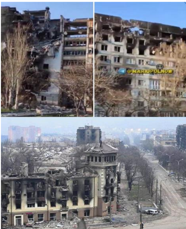
圖11 馬里烏波爾城鎮建築遭空襲毀損狀況
