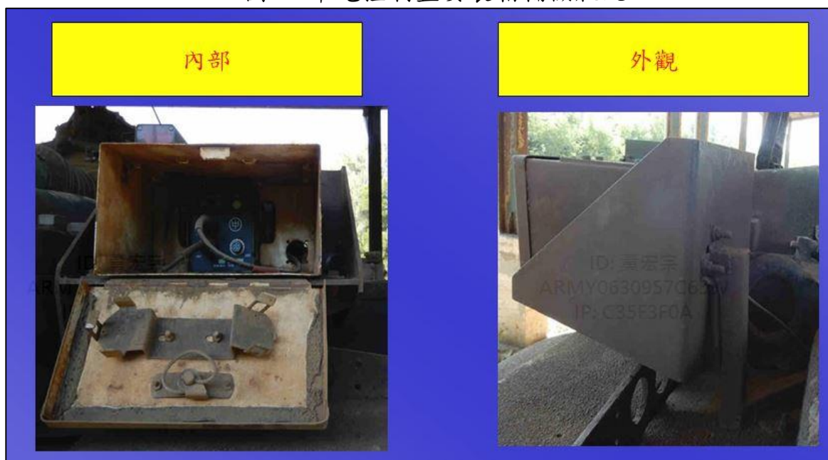
圖31-車尾控制盒安裝箱輔檢狀況
