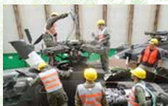
人員安裝吊掛
