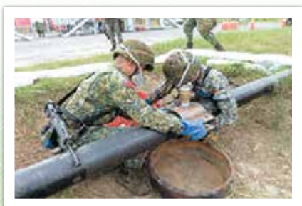
圖16 補油庫執行油管搶修演練
