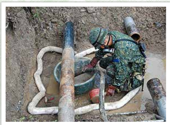
圖6 補油部隊模擬敵火下實施油管搶修作業
