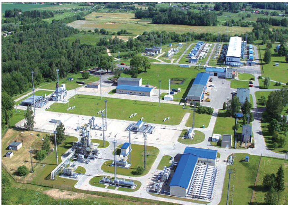
拉脫維亞因庫卡恩斯市地下天然氣儲存設施，存量可達44億7,000萬立方公尺。(Source: Skulte LNG Terminal)
