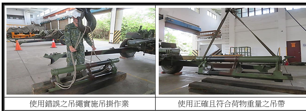
圖 4 使用起重機實施吊掛作業
