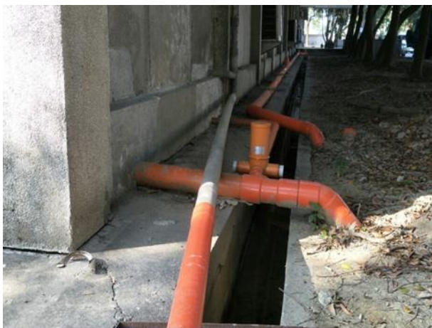
圖18 接戶管路直接搭接 資料來源：A1營區提供。
