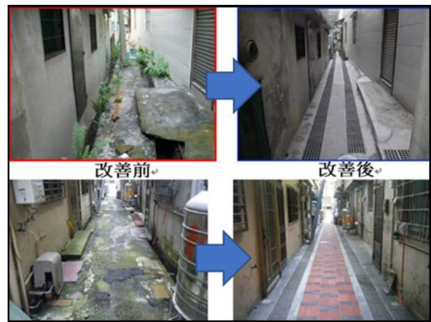
圖27 台中市○○區接戶管路環境改善照片
