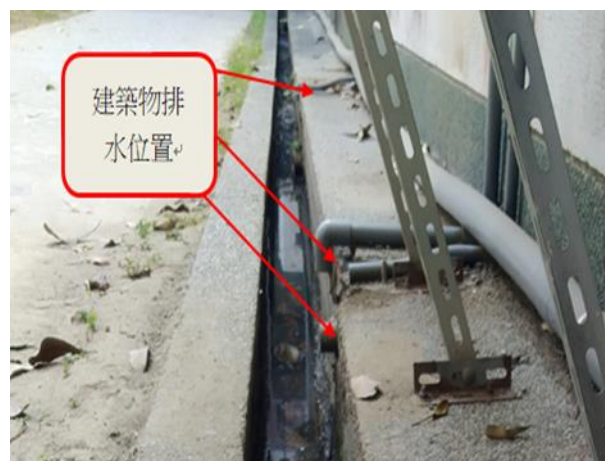
圖5 建築物廢(污)水未集中接管排放 資料來源:作者自行拍攝繪製。
