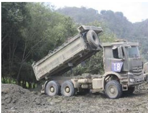
圖20 傾卸車倒土於邊坡以護坡
