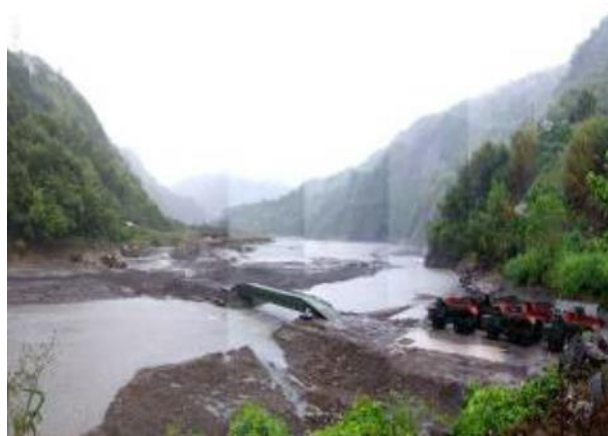
圖3 運用MGB中框橋架設便道 資料來源：李銘正少校陳雅雯上尉，《國軍支援河川疏濬作業模式之研究》(高雄市：陸軍工兵半年刊130期，西元2007年)，頁189。
