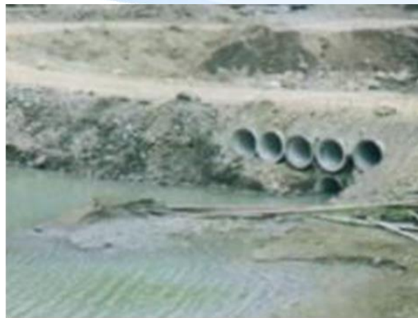
圖15 開設涵管便道
