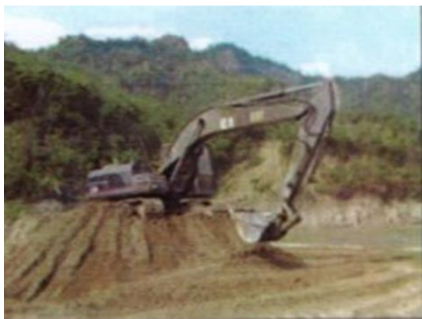
圖11 挖土機作業情形
