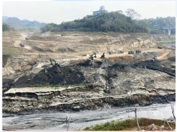
圖6 工兵機械聯合作業圖 資料來源：作者參考節錄石門水庫清淤任務紀實照片。
