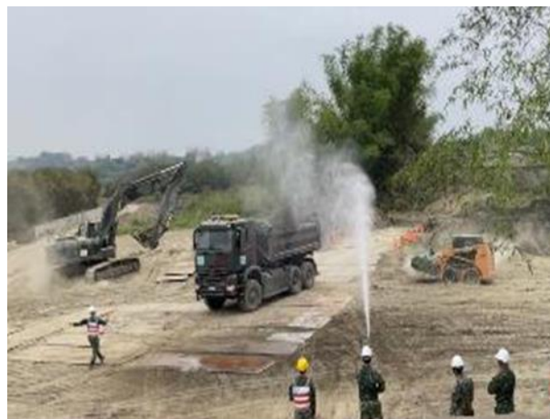
圖26 高壓霧狀水槍降低揚塵
