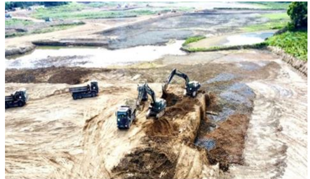
圖24 明德水庫清淤全景圖 接受民視新聞採訪 資料來源：第53工兵群明德水庫清淤工程施工紀實，桃園市，西元2021年，頁268。
