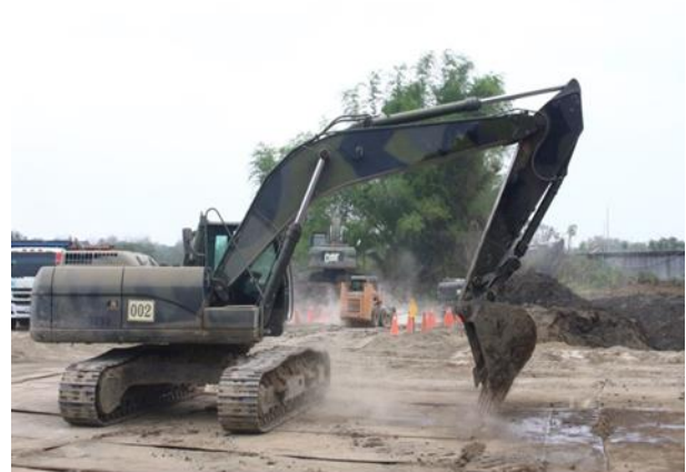
圖34 開挖區挖土機協助鋼板鋪設圖 資料來源：作者蒐整陸軍工兵訓練中心110年阿公店水庫清淤工程施工紀實。
