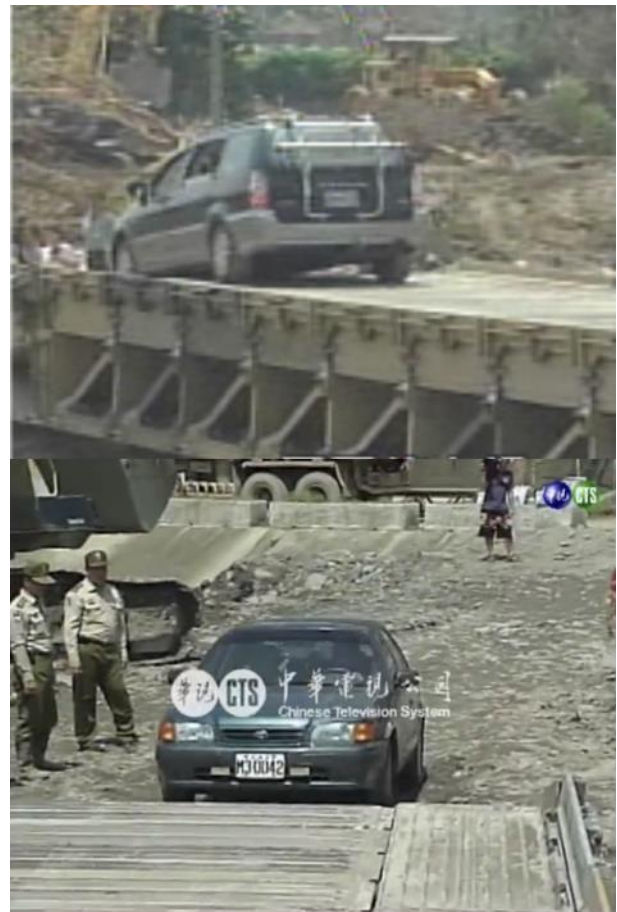
圖14 MGB中樑橋完成架設車輛通行景況
