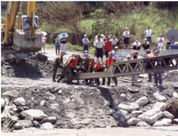
圖12 MGB中樑橋橋礎整備
