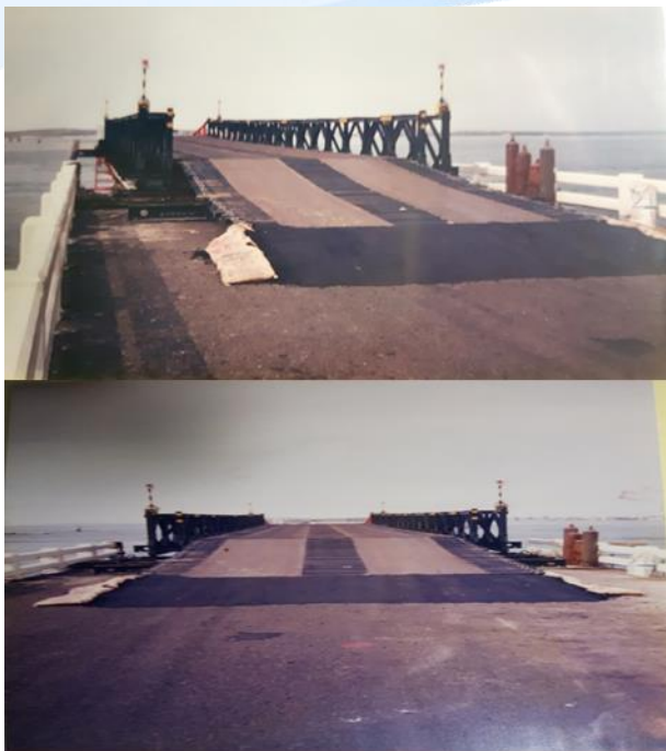
圖6 工兵部隊架設M2桁桁橋完成架設 資料來源：胡一平先生提供。
