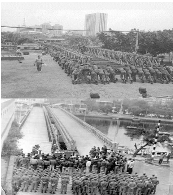
圖9 民國71年國軍工兵部隊高雄仁愛河架設M2 框桁橋
