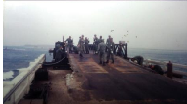
圖5 工兵部隊架設M2桁桁橋現況
