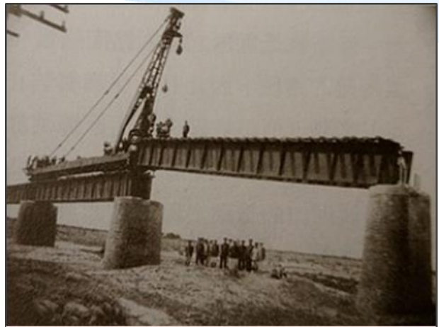
圖15 民國11(1922)年第一代鋼鉸橋樑施工照 資料來源：蔡龍保，《推動時代的巨輪：日治中期的臺灣國有鐵路(1910—1936)》臺北市：臺灣書房，西元2007年7月。
