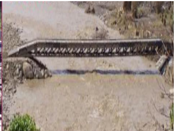
圖13 屏東楓港斷橋架設MGB中樑橋
