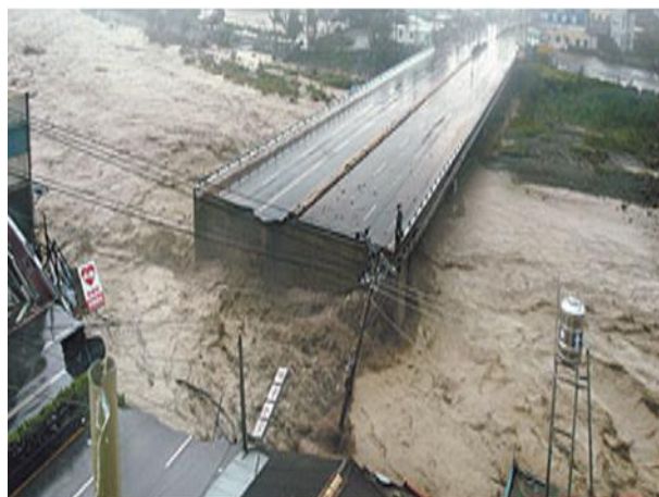
圖11 楓港大橋遭溪水沖毀橋面
