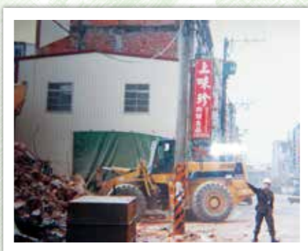
圖13 官兵協助工兵部隊執行危樓拆除工作，並協助指揮道路交通
