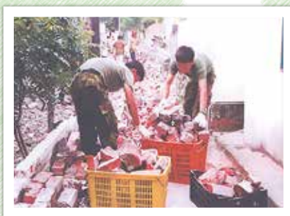
圖13 航特官兵協助清運巷道倒塌牆磚
