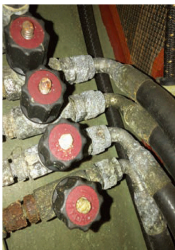
圖1：液壓控制單元與懸吊支架腐蝕、外層油漆脫落，導致內層金屬裸露。(Source: Eric Brown)
