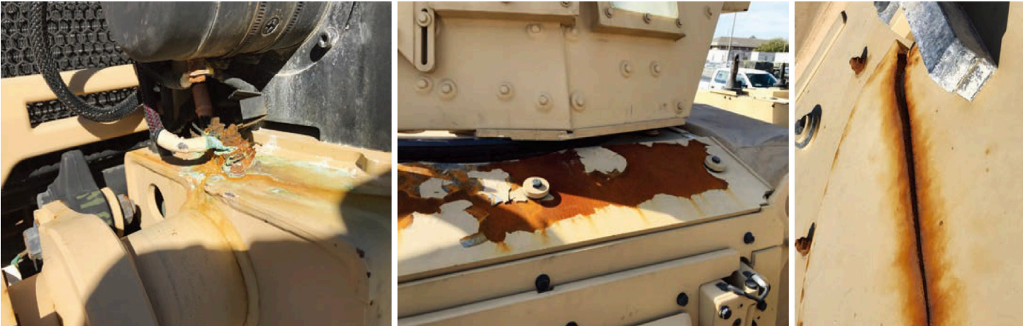
圖2：電氣接頭腐蝕與油漆脫落導致裝備腐蝕。(Source: Eric Brown)
