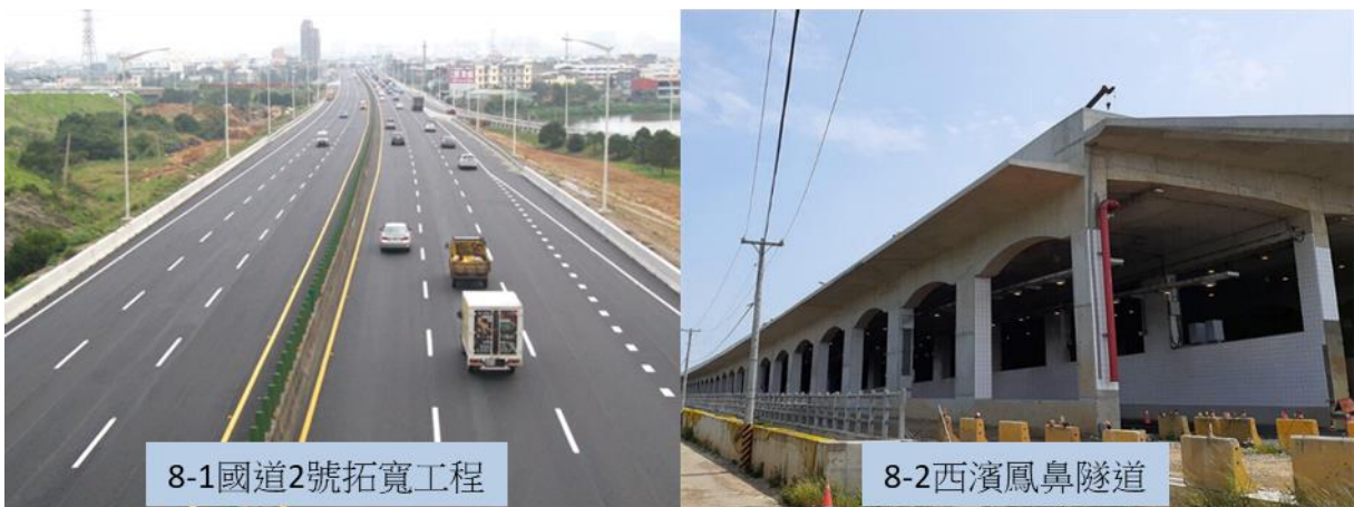
圖 8 早強混凝土道路應用實例
