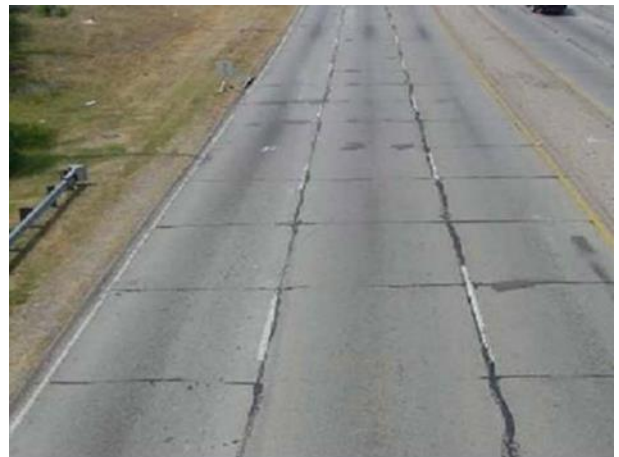
圖 1 鋪面之反射裂縫
