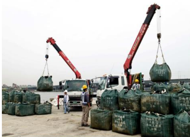
圖 32 機械協助砂袋吊運堆疊
