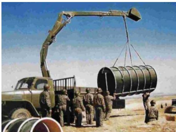
圖 31 機械吊運預鑄式工事
