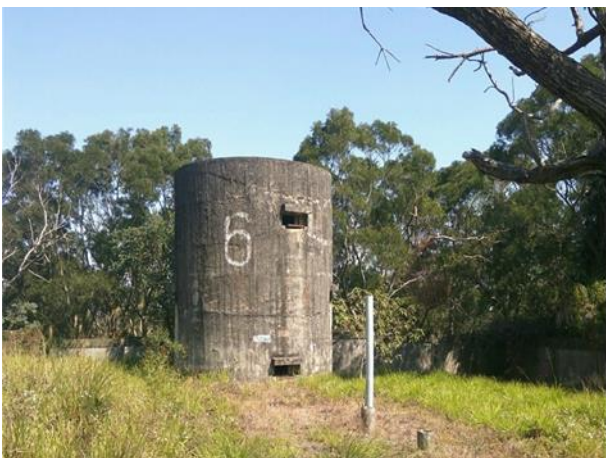
圖 21 機槍堡 資料來源：〈戰後林厝6號反空降堡〉，《國家文化資產網》， https://nchdb.boch.gov.tw/assets/overview/historicalBuilding/20131216000005 檢索日期：西元 2023年3月6日。
