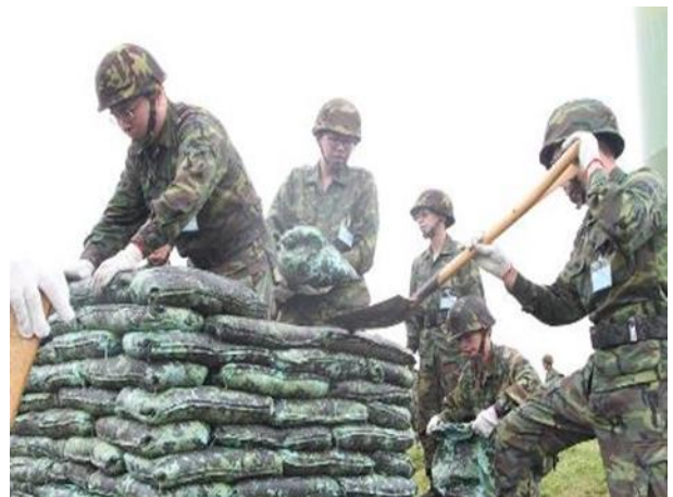
圖 25 人力構築砂袋掩體
