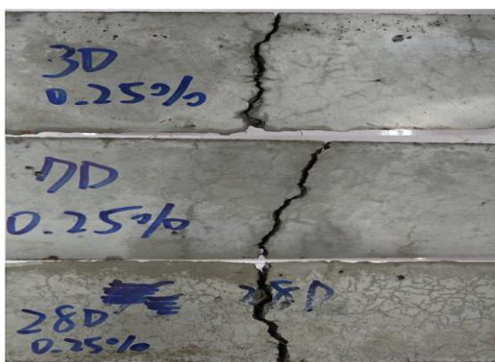
圖12 鋼纖維混凝土樑側面
