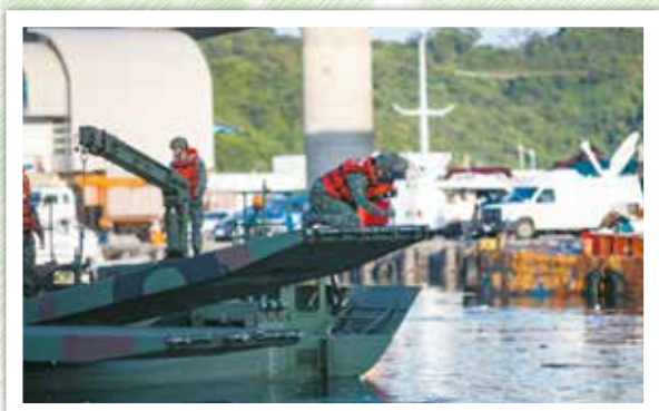
圖8 53工兵群架設M3浮門橋
