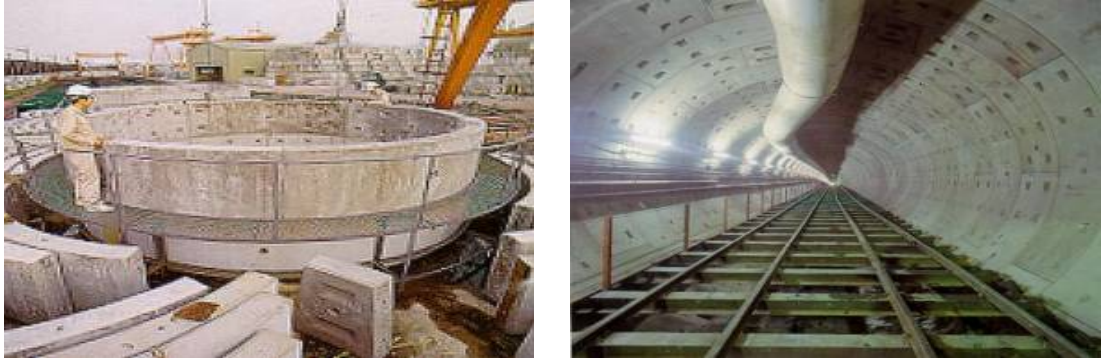
圖 5.10 預鑄環片組立及環片完工全景（引自營建署網站）
