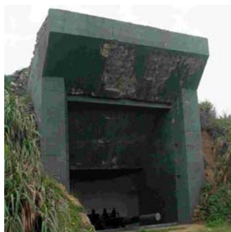
圖 5.5 混凝土永久固定式砲兵掩體
