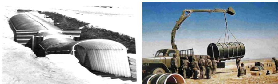
圖 2.3 型鋼構件掩體掩體
